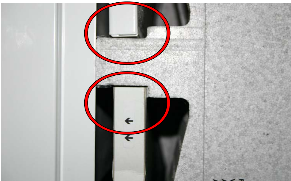
Abbildung 9: Lüftungsgerät mit Außenluftfilter, von Vorderseite betrachtet, Falschluff durch unzureichenden Sitz der Filters (Tappler 2005)
